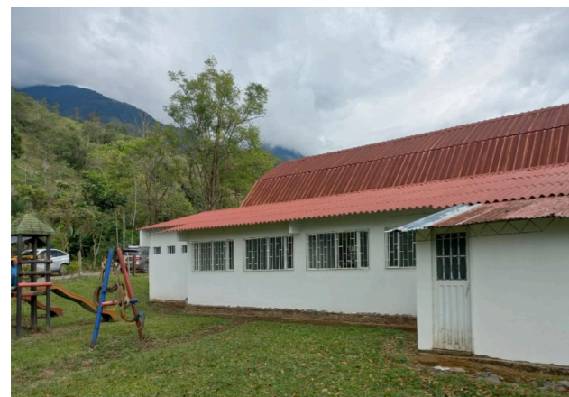
Mejoramiento Escuela Rural Boca de Monte - Mámbita
